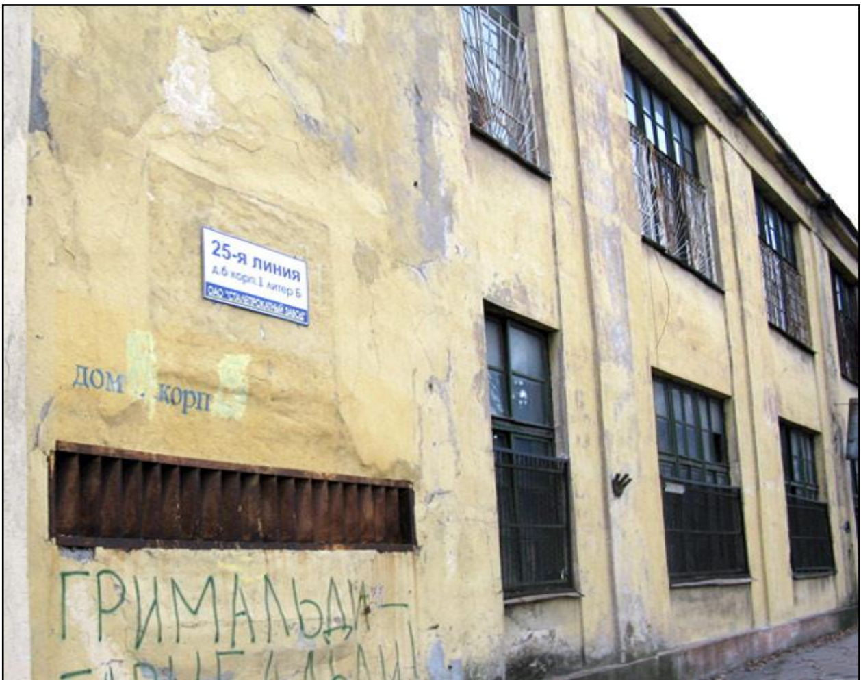
Рисунок 25 (фото автора). Главное здание завода.
