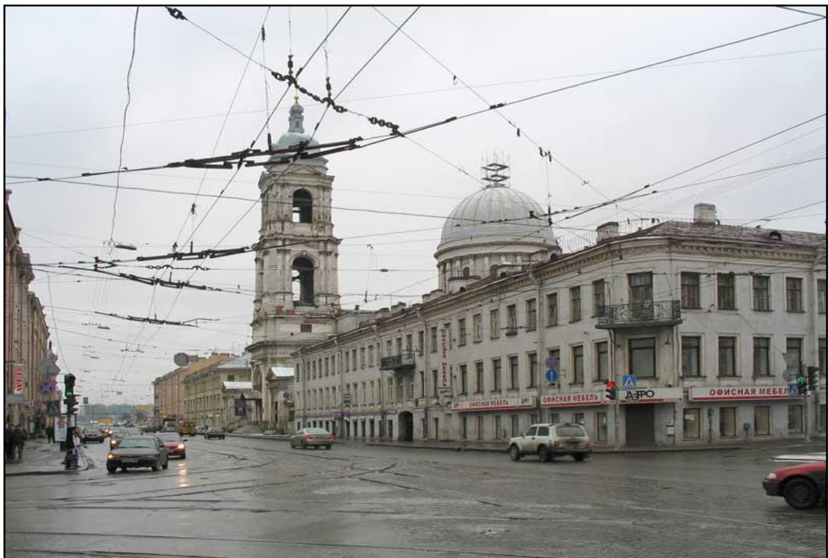
Рисунок 2. Церковь Святой Екатерины: вид до реставрации.
